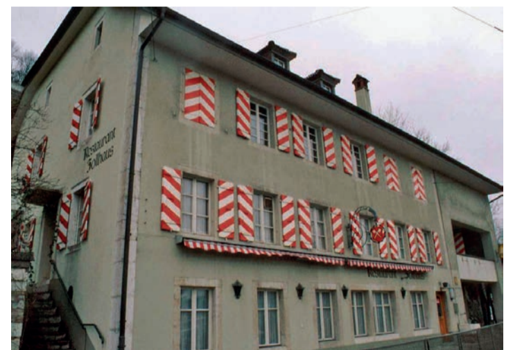
In der Liegenschaft Solothurnstrasse 85 (Zollhaus) wird eine Jugendherberge mit 50 Betten einziehen.
